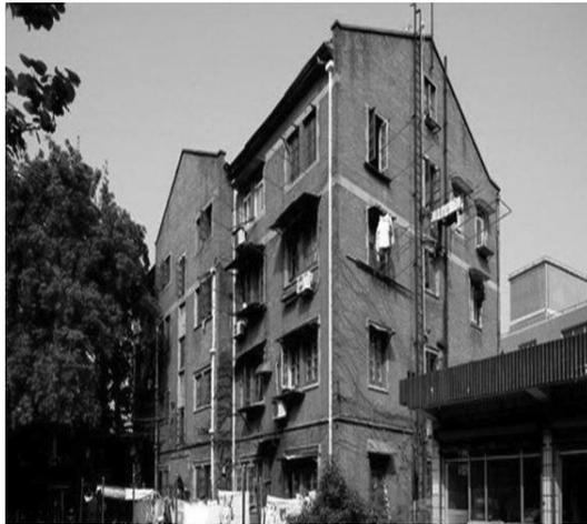
图 1-7 砖混结构
